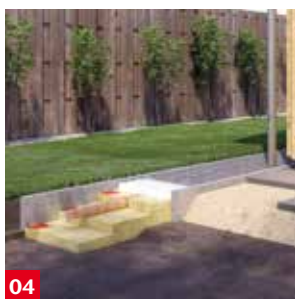
Infiltratie in een brede opvang-goot langs aanbouw of veranda
