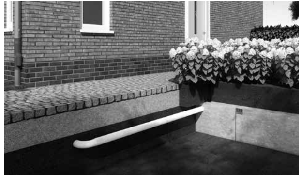
06 - Infiltratie op de zuidzijde van de woning
