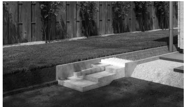
04 - Infiltratie in een brede opvanggoot langs aanbouw of veranda
