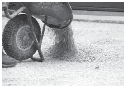
Aanbrengen van de vul en deklaag
